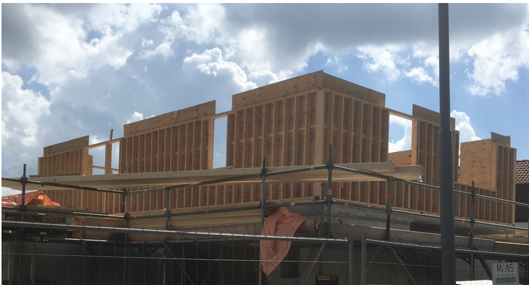
Figuur 6-5 Houtskeletbouwconstructie
