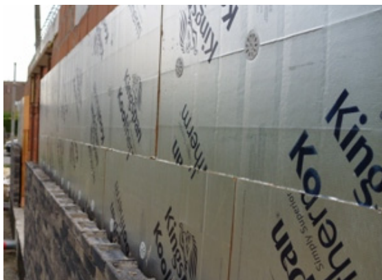
Figuur 4-4 Isolatie met een warmte-reflecterende laag aan de spouwzijde (Bron: Kingspan Kooltherm K8)
