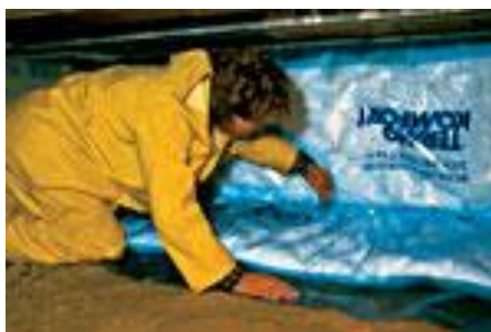
Systeem III.d Bodemhygralatie (bron Termokomfort)
