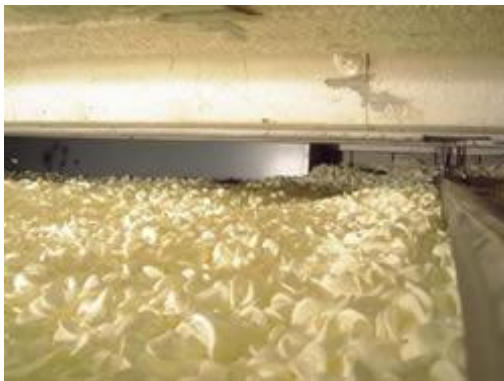
Systeem III.b/c Bodemislatie met polystyreen schelpen of parels (bron DroCom)
