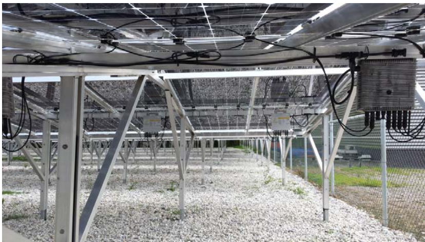
Figuur 13. Een zonnepark met micro-omvormers
