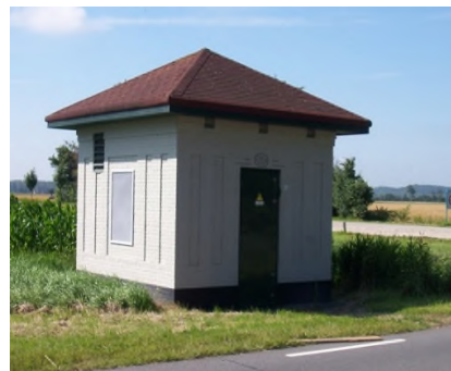
Figuur 2.4 Voorbeeld van transformatorhuisje
